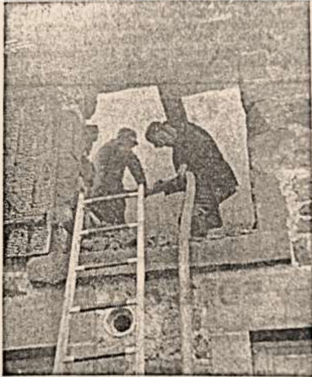
Auch durch Dachfenster wurde der Brandherd „unter Beschuß“ genommen.
